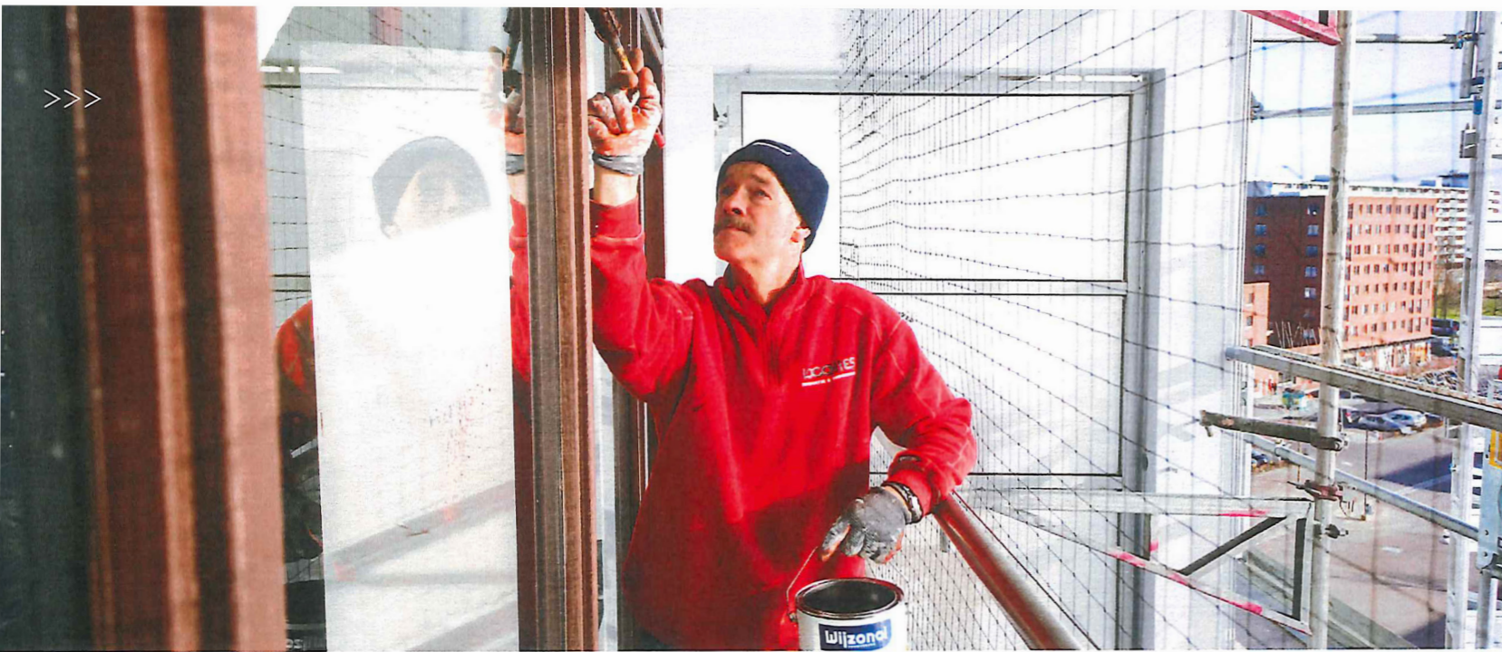
▲ Het houtwerk van galerijflat Gravestein krijgt een 1,5 beurt, met als toplaag Wijzonol LBH SDT Ultra Hoogglanslak.
