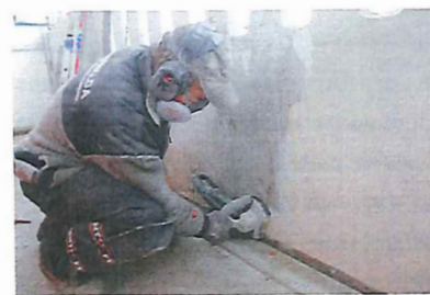
▲ Het mechanisch reinigen van de betonnen borstweringen door één van de medewerkers van Buwalda.
